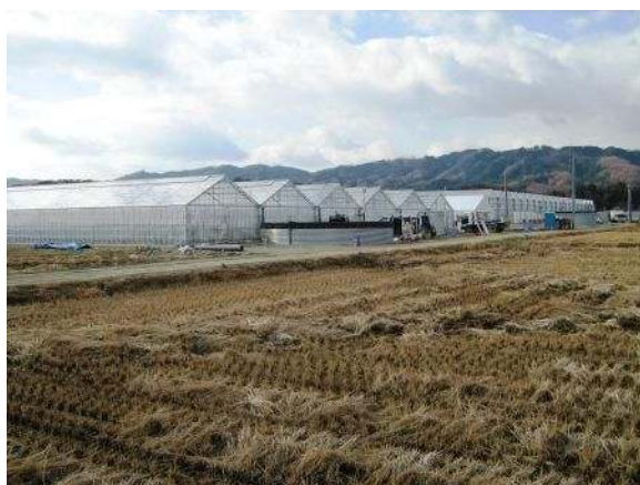
完成した最新設備の大型ハウス
