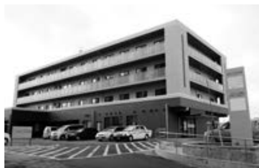
平成25年2月竣工の福祉施設
