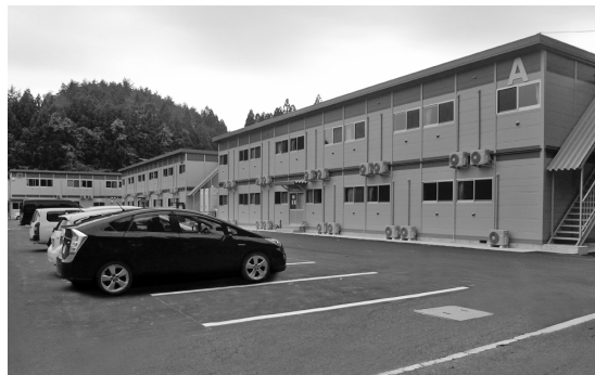
完成した作業員用寄宿舎
