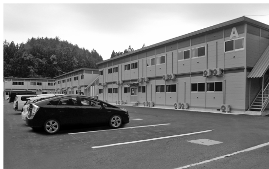
完成した作業員用寄宿舎
