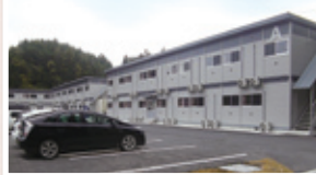
作業員寄宿舎を建築 (平成25年8月に完成)
