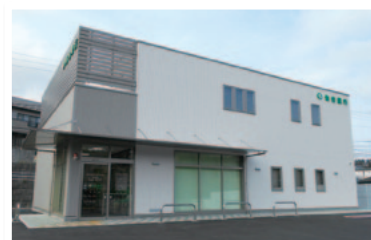
新築オープンした歌津支店
