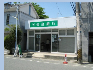
仮設店舗で営業再開した塩釜支店
